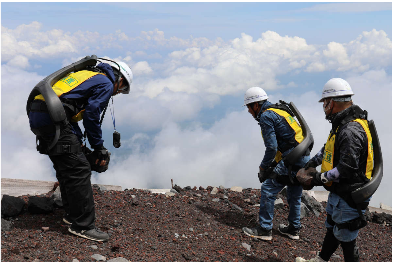
パワードウェアを用いた山道整備の様子
